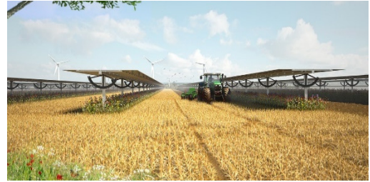
Zum Bewirtschaftungsmodus „Ackerland“ werden die Modultische waagrecht gestellt. Darunter kann z.B. gepflügt werden. © EWS Consulting GmbH
